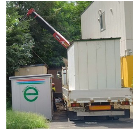
トラックに積んだ物置とクレーンで吊り上げ中の物置
