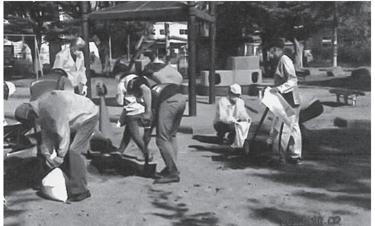
土のうの砂つめ作業
