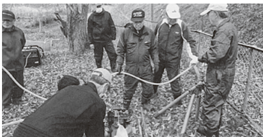
▲自家発電機で地下水汲み上げ
